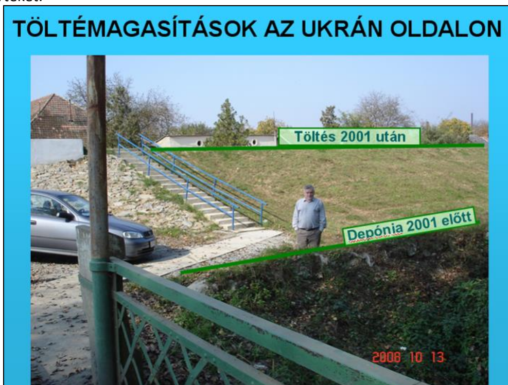
22. ábra Töltésmagasítások az ukrán oldalon
